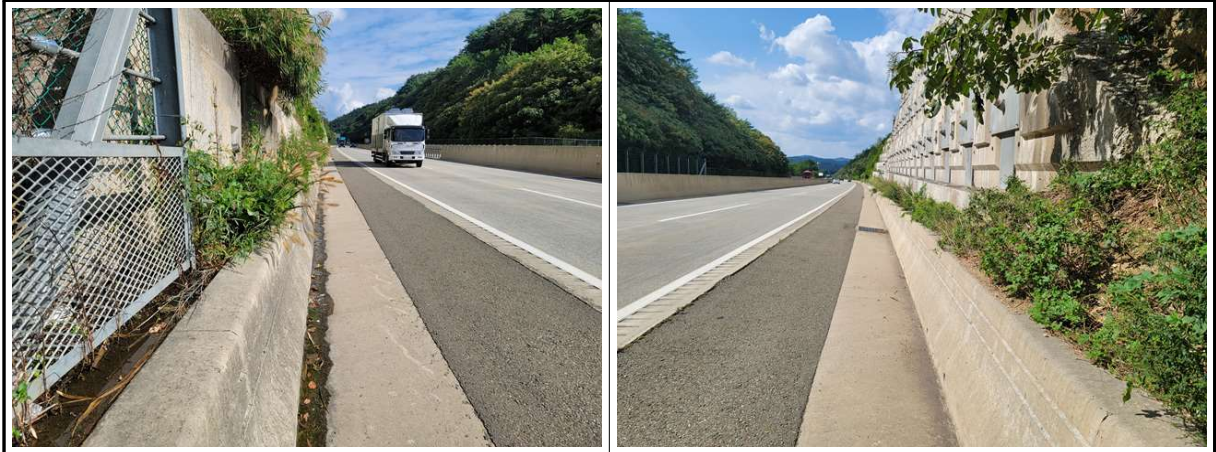
【사진 10.3.1】 지반, 기초부 전경
