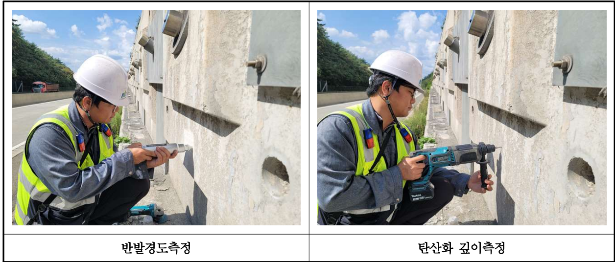
【사진 10.4.1】 재료시험 조사 전경
