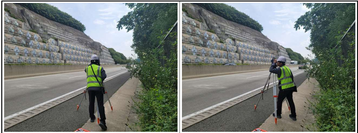
【사진 10.4.2】 측량작업 전경
